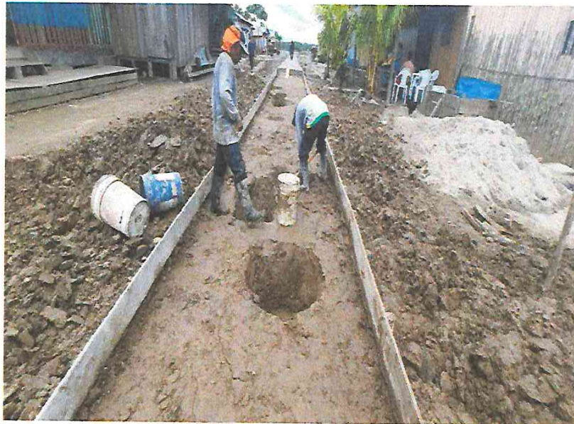
FOTO N° 09: SE OBSERVA EXCAVACIÓN MANUAL EN VEREDAS EN LA COMUNIDAD DE HUACRACHIRO.
