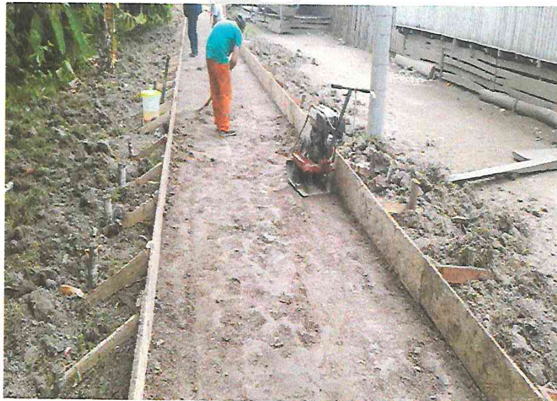
FOTO N° 12: SE OBSERVA COLOCACION DE CAMA DE ARENA, ENCOFRADO EN VEREDAS Y COMPACTACIÓN DE TERRENO EN LA COMUNIDAD DE BELLAVISTA.
