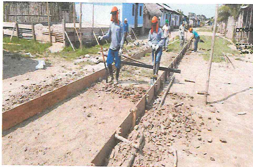
FOTO N° 06: SE OBSERVA ENCOFRADO EN VEREDAS, Y EXCAVACIÓN MANUAL EN LA COMUNIDAD DE HUACRACHIRO.
