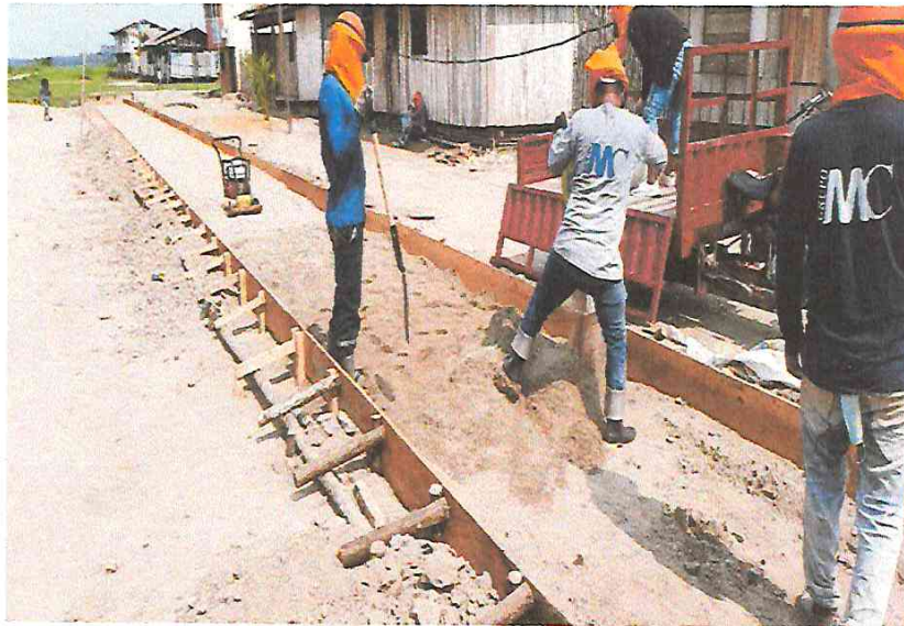
FOTO N° 07: SE OBSERVA ENCOFRADO EN VEREDAS, COLOCACIÓN DE CAMA DE ARENA, Y COMPACTADO DE MATERIAL EN LA COMUNIDAD DE HUACRACHIRO.
