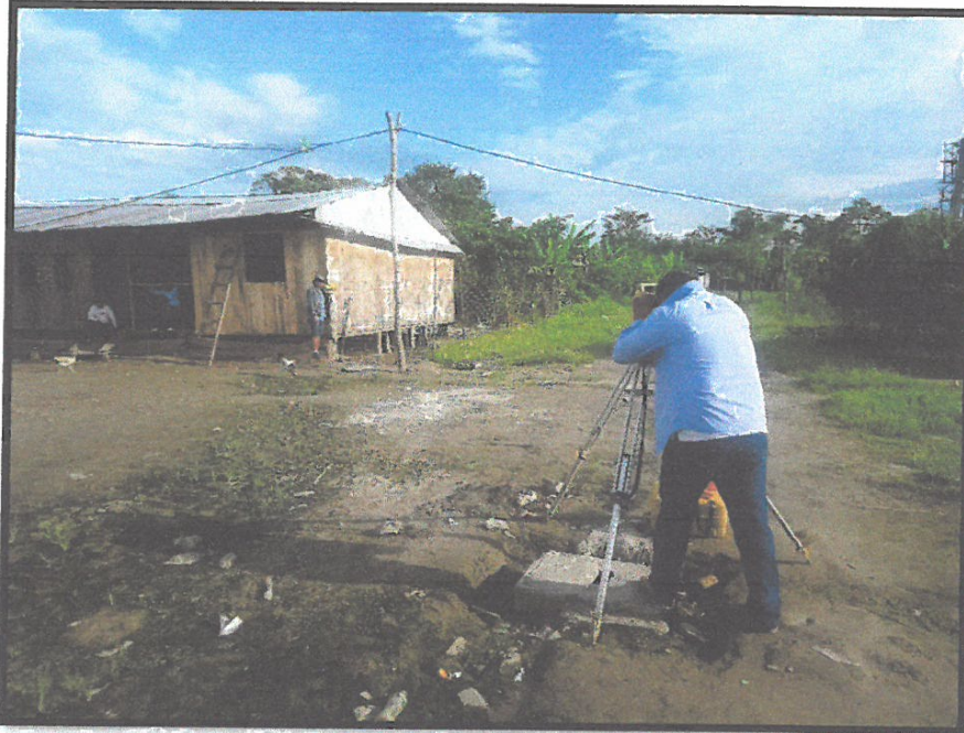
FOTO N° 01: Se puede observar los trabajos de Replanteo de la Obra en Huacrachiro
