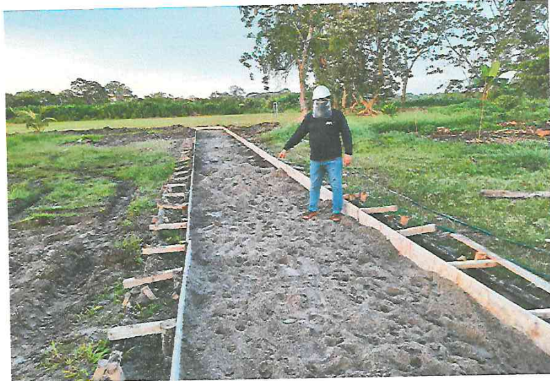
FOTO N° 03: SE OBSERVA COLOCACIÓN DE CAMA DE ARENA EN VEREDAS, EN LA COMUNIDAD DE HUACRACHIRO.
