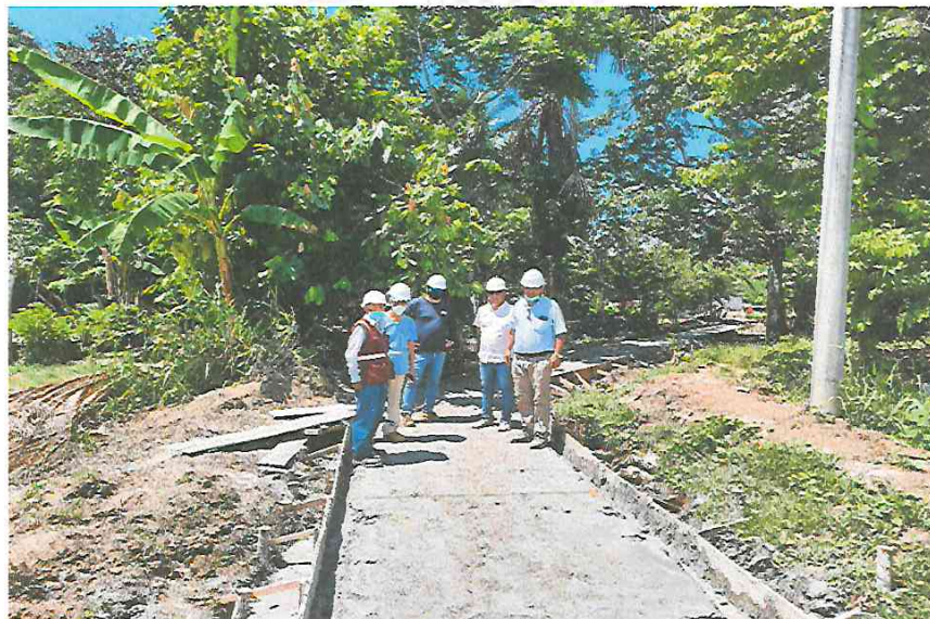
FOTO N° 10: SE OBSERVA TRABAJOS DE ENCOFRADO, EXCAVACIÓN MANUAL, COLOCACIÓN DE CAMA DE ARENA Y VACEO DE SOLADO EN VEREDAS EN LA COMUNIDAD DE ANCASH.
