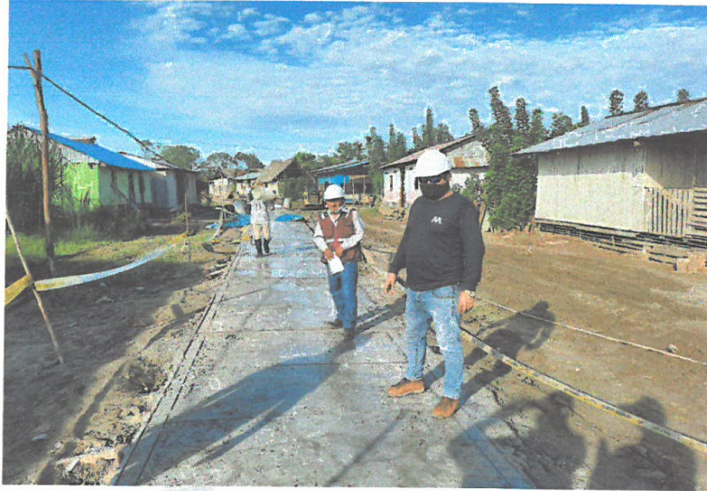
FOTO N° 07: SE OBSERVA CURADO EN VEREDAS EN LA COMUNIDAD DE HUACRACHIRO.
