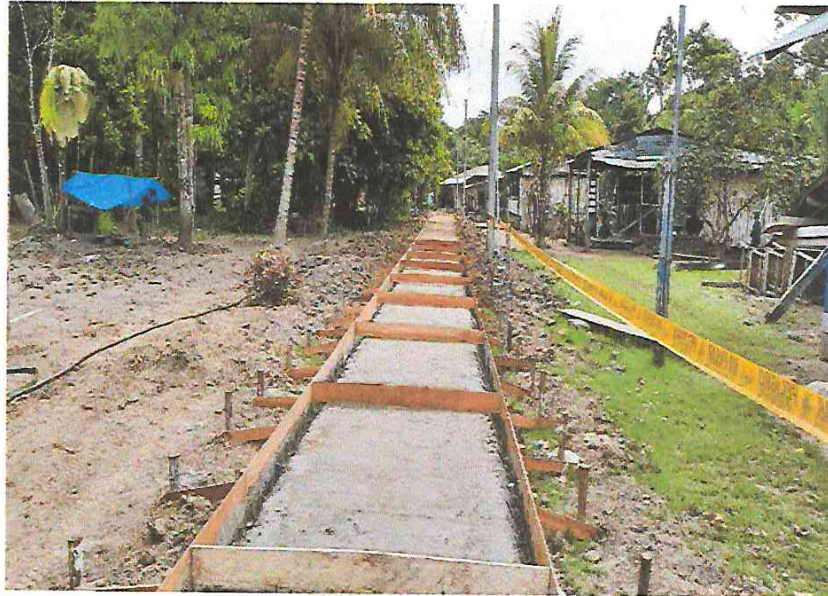
FOTO N° 13: SE OBSERVA ENCOFRADO DE VEREDAS EN LA COMUNIDAD DE BELLAVISTA.
