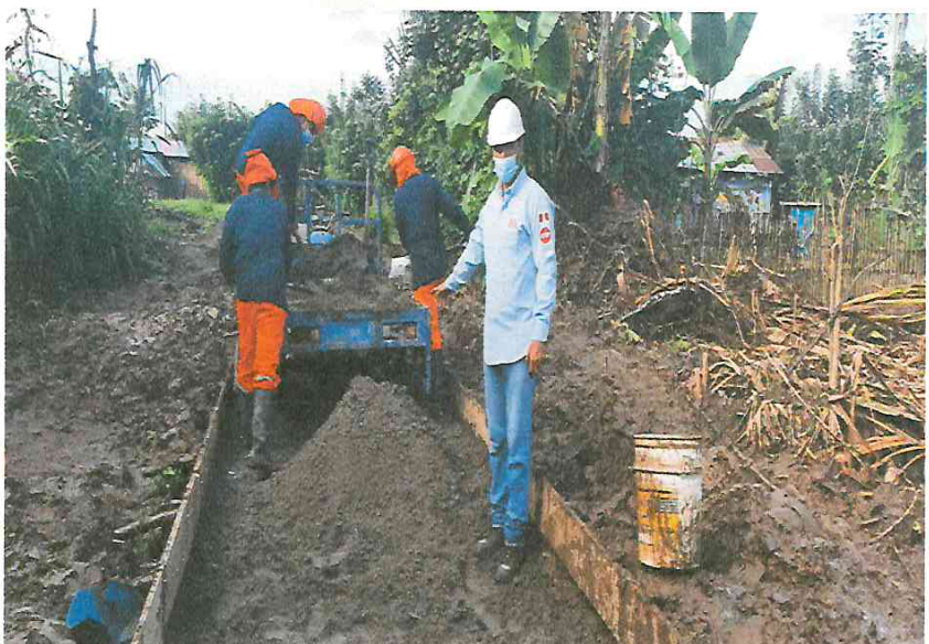
FOTO N° 07: SE OBSERVA ENCOFRADO EN VEREDAS, COLOCACIÓN DE CAMA DE ARENA, Y COMPACTADO DE MATERIAL EN LA COMUNIDAD DE SAN CARLOS.
