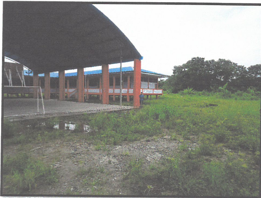
FOTO N° 02: Se puede observar los trabajos de Replanteo de la Obra en Huacrachiro
