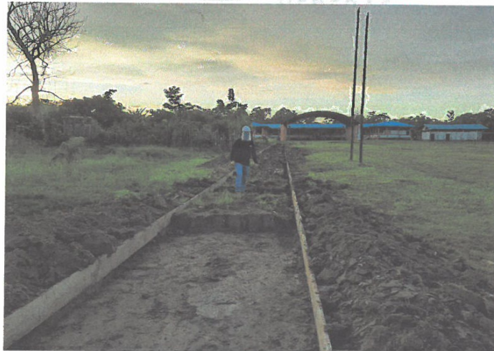
FOTO N° 02: SE OBSERVA ENCOFRADO EN VEREDAS, Y EXCAVACIÓN MANUAL EN LA COMUNIDAD DE HUACRACHIRO.
