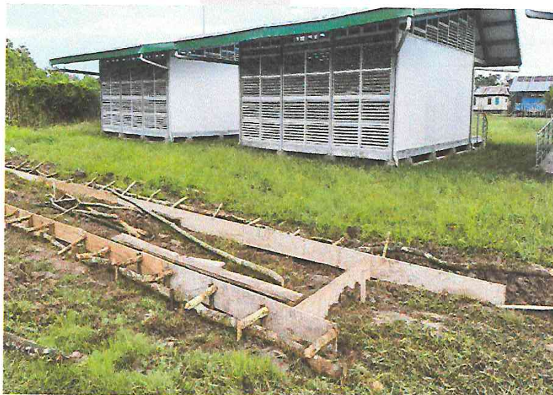
FOTO N° 10: SE OBSERVA ENCOFRADO EN VEREDAS Y EXCAVACIÓN MANUAL DE ZANJAS EN LA COMUNIDAD DE HUACRACHIRO.
