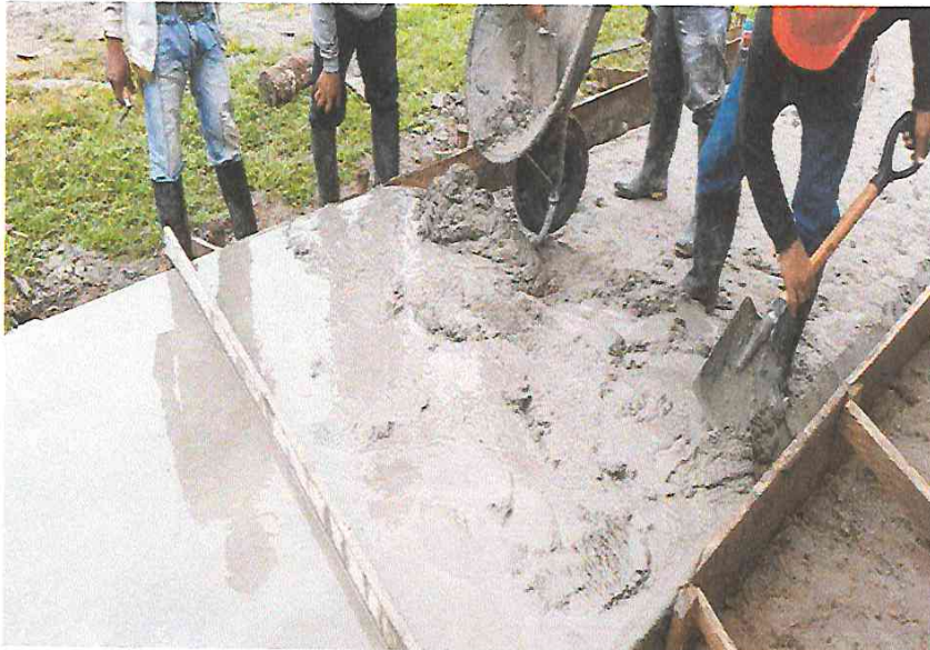
FOTO N° 17: SE OBSERVA VACEO DE MORTERO EN LA COMUNIDAD DE ANCASH. JV Ing. JUAN VICTOR ACEVEDO VASQUEZ Jefe de Supervisión - CIP 123510
