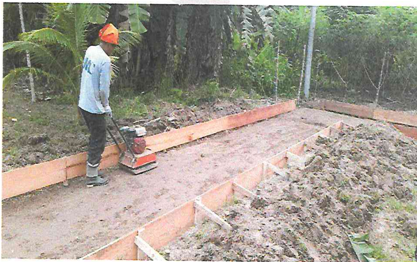
FOTO N° 13: SE OBSERVA ENCOFRADO DE VEREDAS EN LA COMUNIDAD DE BELLAVISTA.
