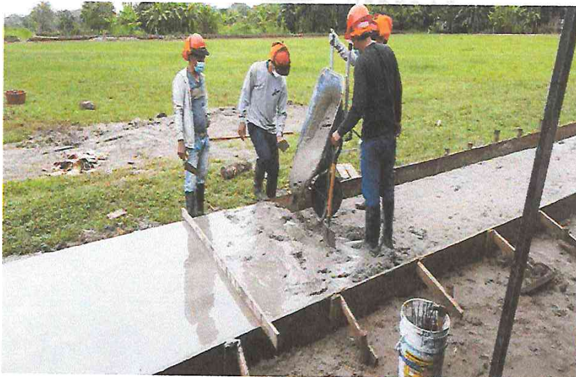
FOTO N° 18: SE OBSERVA VACEO DE MORTERO EN LA COMUNIDAD DE ANCASH.
