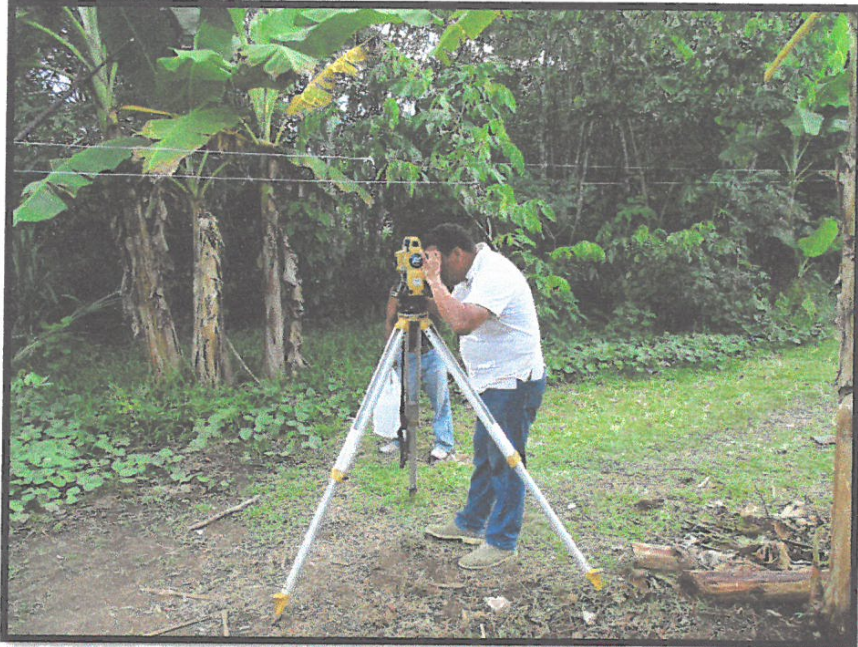
FOTO Nº 05: Se puede observar los trabajos de Replanteo de la Obra en Ancash
