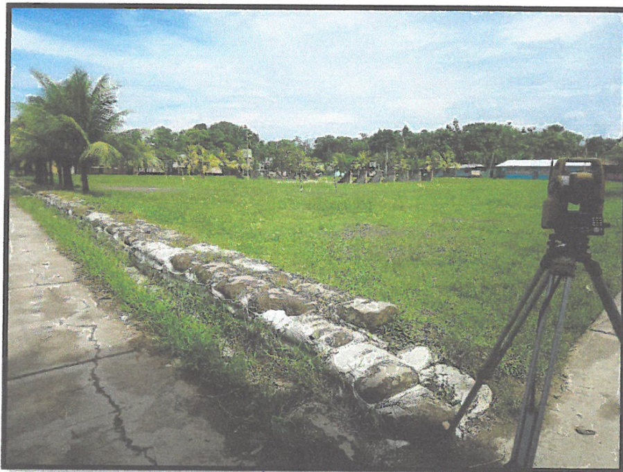
FOTO Nº 06: Se puede observar los trabajos de Replanteo de la Obra en Ancash
