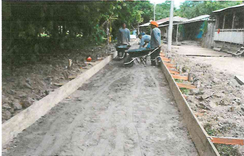
FOTO N° 07: SE OBSERVA ENCOFRADO EN VEREDAS, COLOCACIÓN DE CAMA DE ARENA, Y COMPACTADO DE MATERIAL EN LA COMUNIDAD DE SAN CARLOS.
