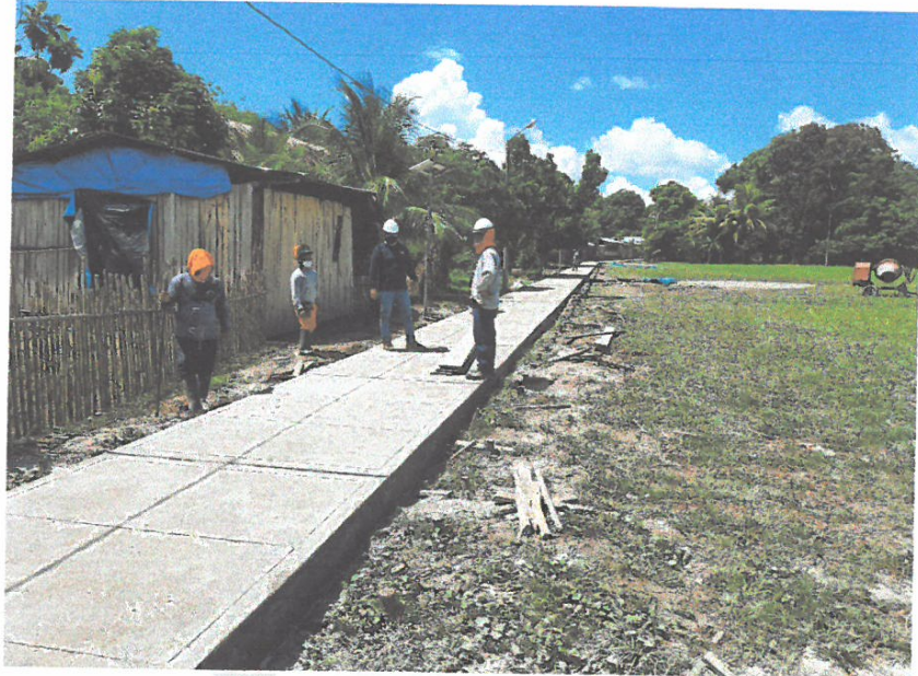
FOTO N° 11: SE OBSERVA TRABAJOS DE VACEO DE MORTERO F'C= 210 KG/CM2 EN VEREDAS EN LA COMUNIDAD DE ANCASH.
