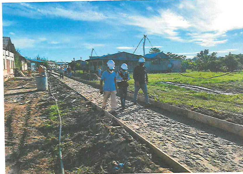
FOTO N° 05: SE OBSERVA VISITA A OBRA DEL ING. ZUMARAN DE SUPERVISIÓN DE LA GRIL, EN PRESENCIA DE LA SUPERVISIÓN EN LA COMUNIDAD DE HUACRACHIRO.
