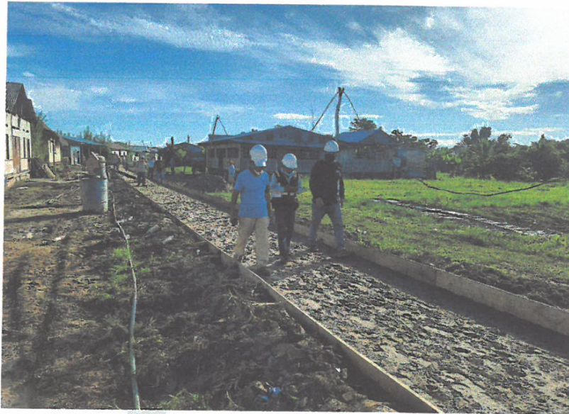
FOTO N° 05: SE OBSERVA VISITA A OBRA DEL ING. ZUMARAN DE SUPERVISIÓN DE LA GRIL, EN PRESENCIA DE LA SUPERVISIÓN EN LA COMUNIDAD DE HUACRACHIRO.
