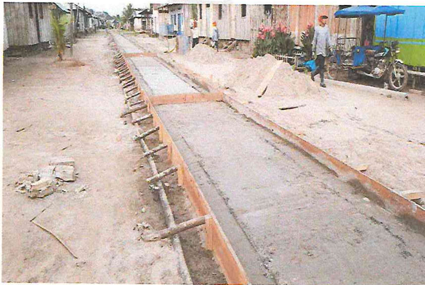
FOTO N° 16: SE OBSERVA COLOCACION DE CAMA DE ARENA, VACEO DE SOLADO Y ENCOFRADO DE VEREDAS EN LA COMUNIDAD DE HUACRACHIRO.
