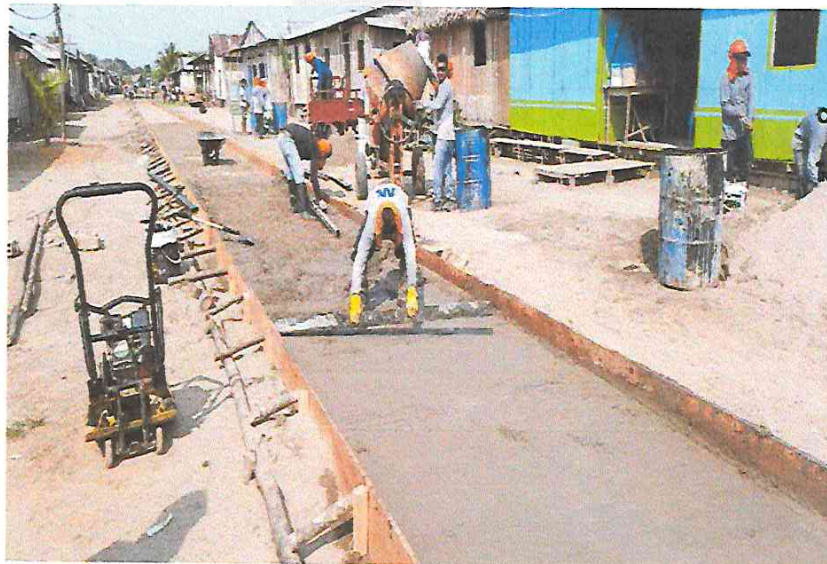
FOTO N° 07: SE OBSERVA ENCOFRADO EN VEREDAS, COLOCACIÓN DE CAMA DE ARENA, Y COMPACTADO DE MATERIAL EN LA COMUNIDAD DE HUACRACHIRO.
