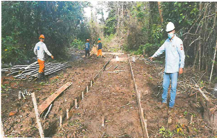
FOTO N° 06: SE OBSERVA ENCOFRADO EN VEREDAS, Y EXCAVACIÓN MANUAL EN LA COMUNIDAD DE SAN CARLOS.
