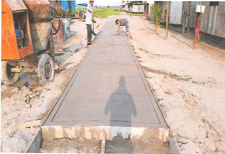
FOTO N° 19: SE OBSERVA TRABAJOS DE BRUÑADO EN LA COMUNIDAD DE HUACRACHIRO.
